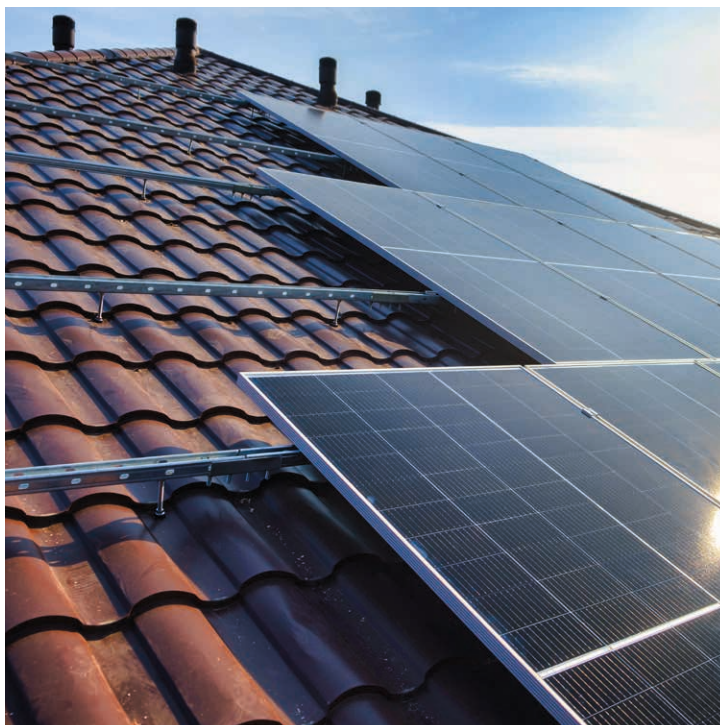
Vor der Installation einer Photovoltaik-Anlage ist es ratsam, einen Dachdecker-Fachbetrieb zu kontaktieren.
