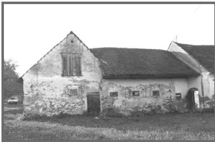
Ansicht vor der Sanierung
