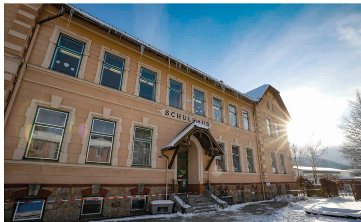
Neben dem revitalisierten Gebäude steht ein weiteres historisches, in dem die Volksschule untergebracht ist, ein spannender Kontrast, findet der Malermeister Hannes Koudelka. Deren Fassade ist für ihn ein Beleg für fachmännische Arbeit: Sie wurde im Jahr 1980 beschichtet und befindet sich nach wie vor in einem sehr guten Zustand.
