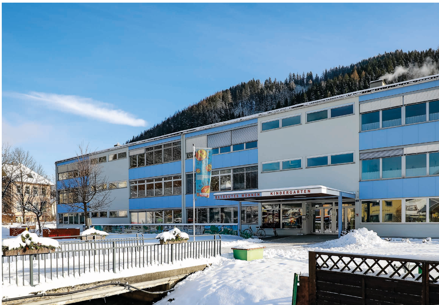
Die sanierte Schule im Stil der Nachkriegszeit
