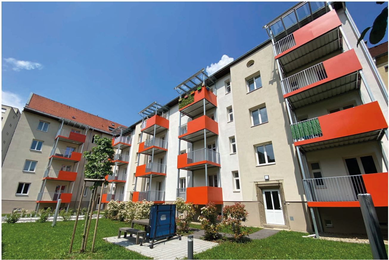
Objekt in Bruck nach einer umfassenden Sanierung
