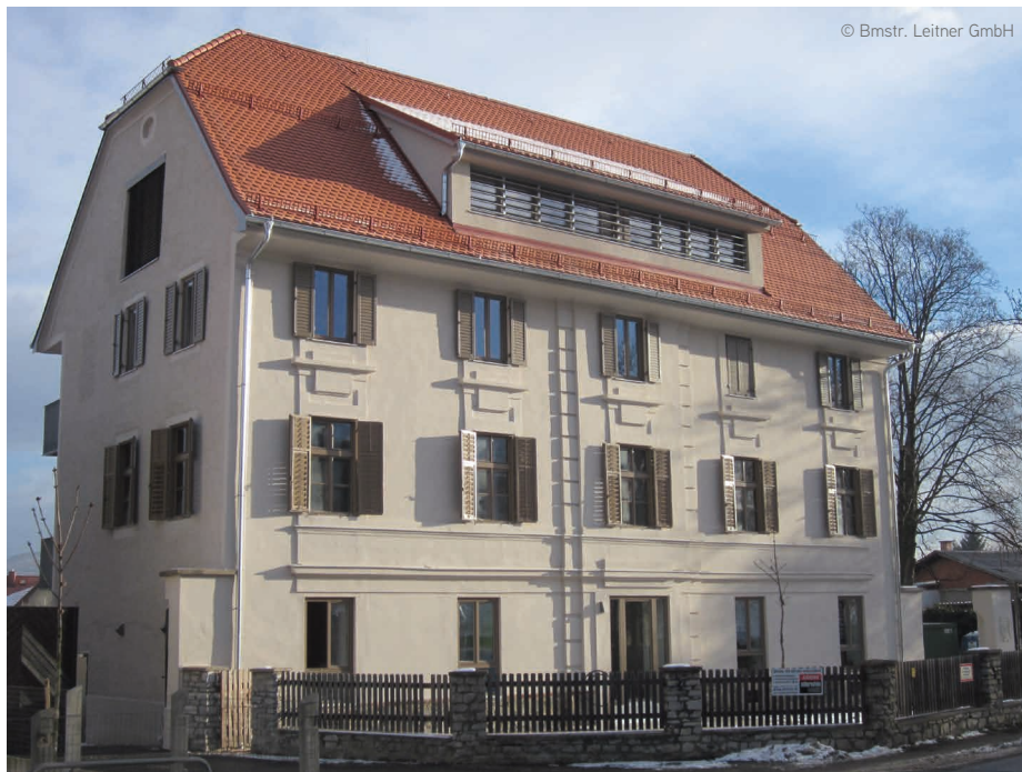
Von Bmstr. Leitner Planungs &amp; Bauaufsicht GmbH saniertes Objekt in Graz
