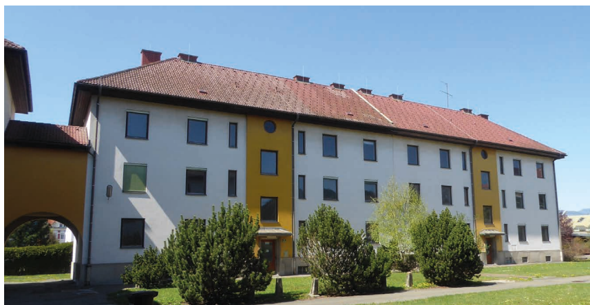
Objekt in der Landschacher Gasse 5-7 in Knittelfeld vor (links) und nach (unten) der Sanierung
